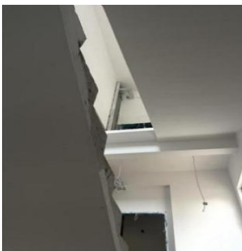
a 楼梯间二楼仰视图
