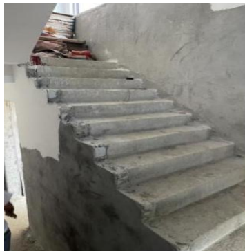
b 二楼至三楼楼梯
