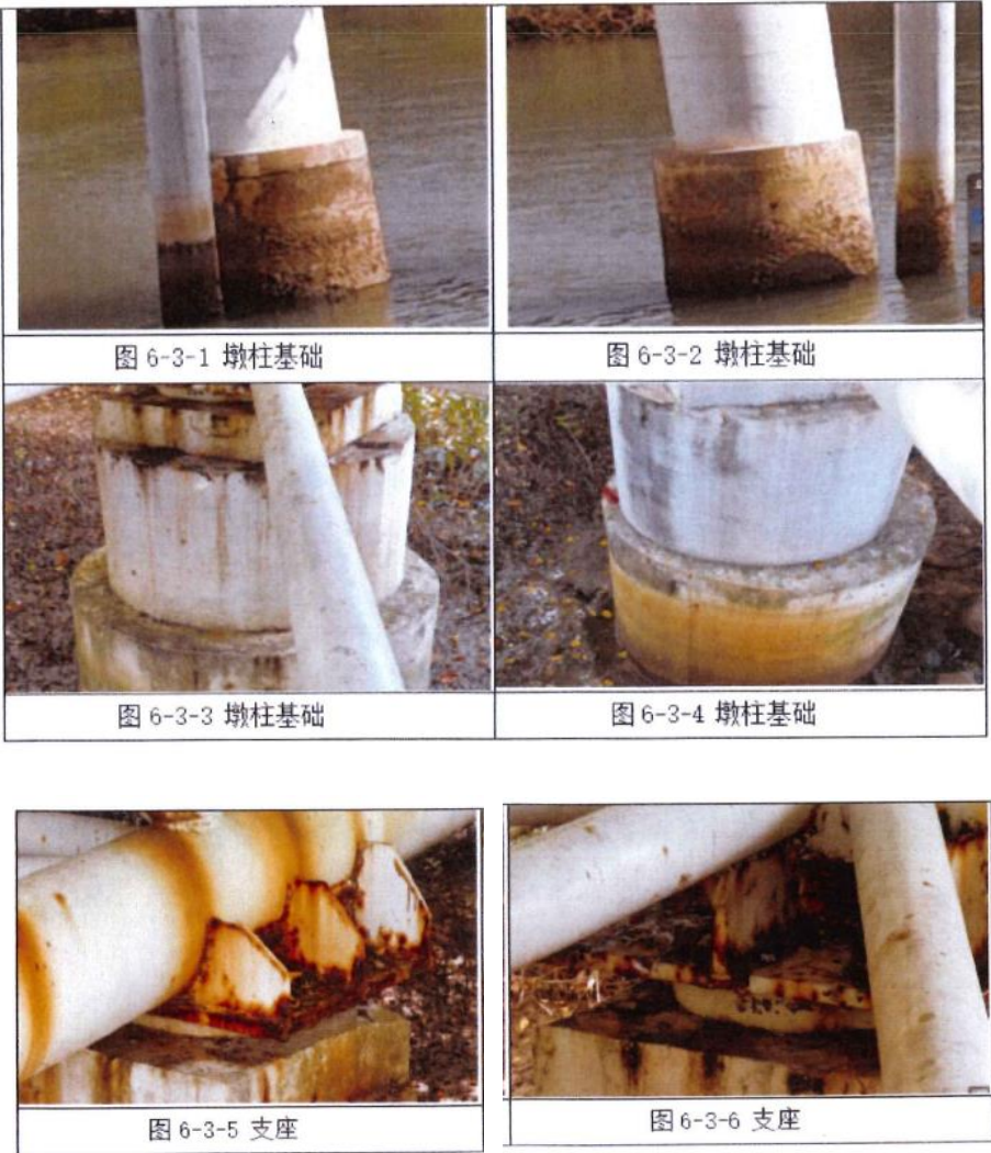
桥墩和支座图片
