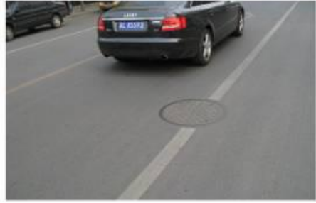
图 26 检查井位于车道线上的示意图及实践案例
