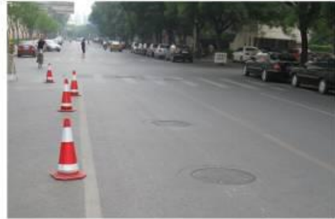
图 27 检查井位于车道中心线的示意图及实践案例
